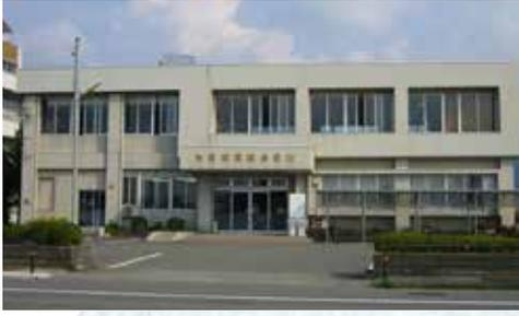
昭和55年3月に建設された長畝公民館(現:のうねの郷コミュニティセンター)は、耐震診断C判定で補強工事が必要と判断。
